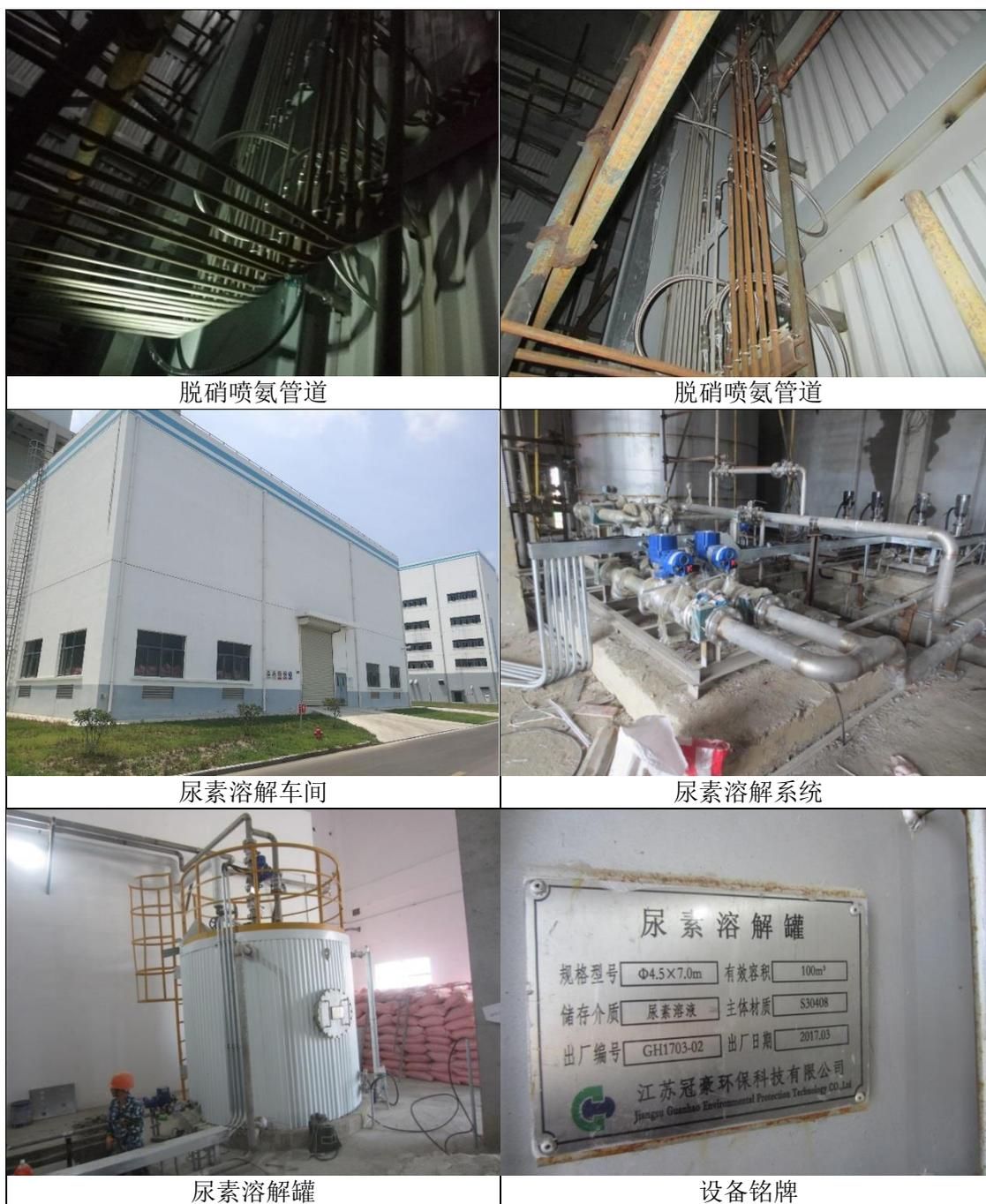
图 4-1-2 SNCR 脱硝装置建设情况
