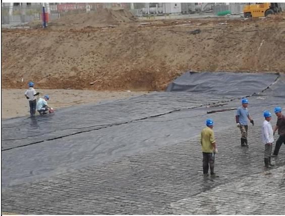
雨水收集池防渗膜施工
