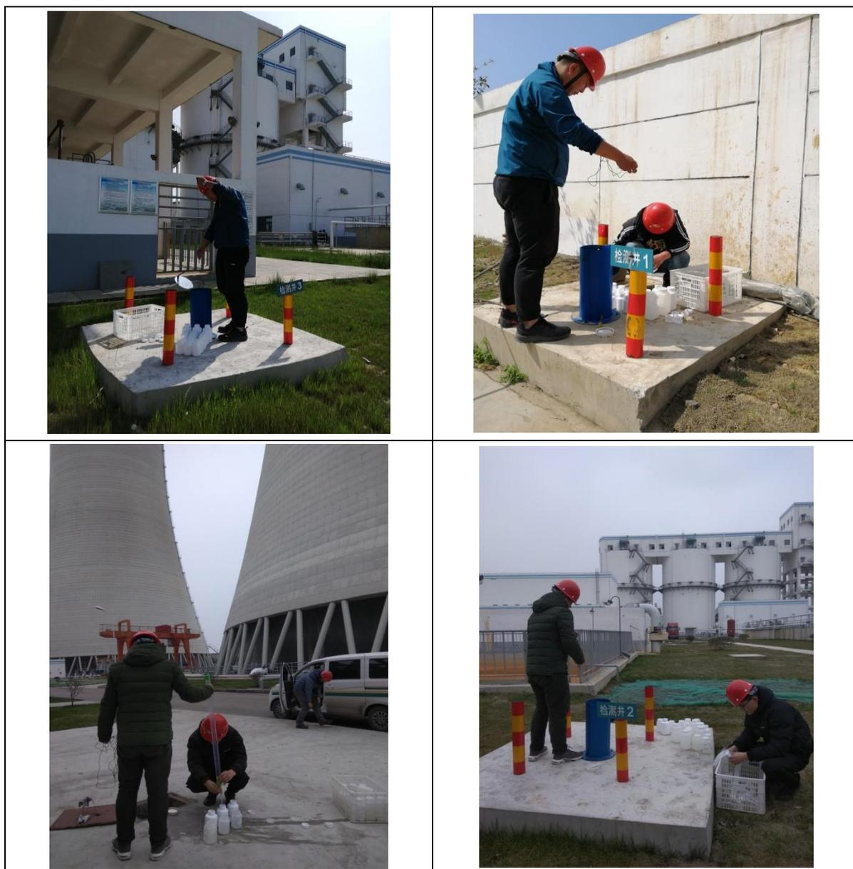
图 4-2-5 地下水监测井及水样监测
