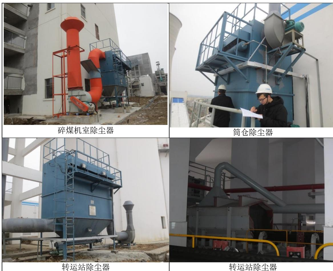
图 4-1-8 输煤系统除尘器建设情况
