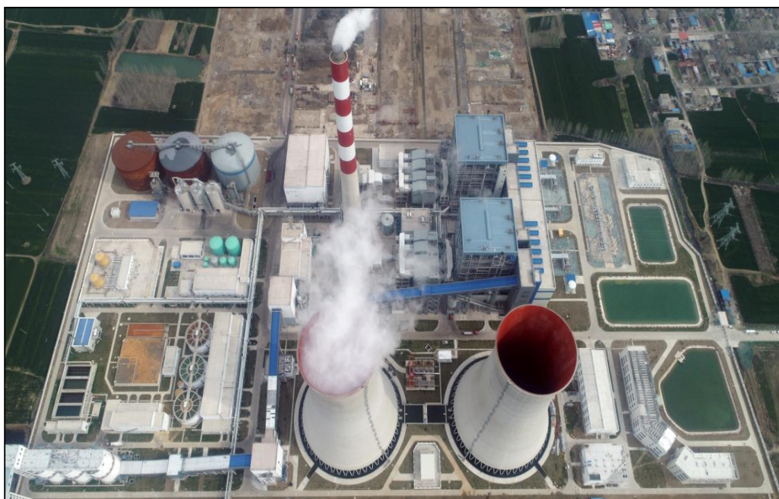
图片 2 厂区建设全貌 2018 年 5 月 22 日
