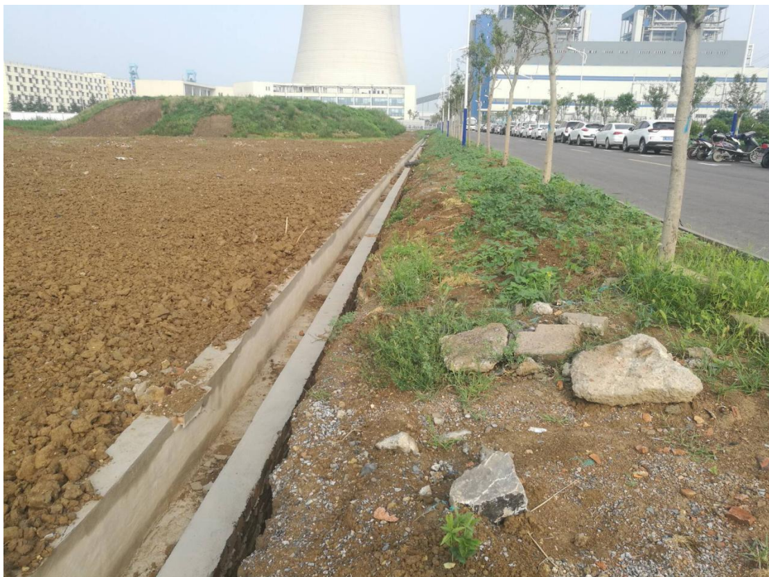
图片 17 进厂道路排水沟
