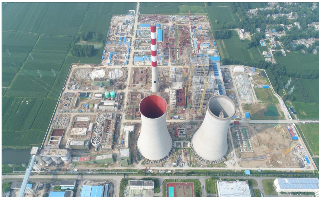
图片 1 厂区建设全貌 2017 年 8 月 9 日
