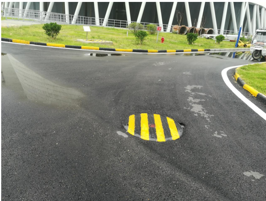
图片 11 厂区雨水井
