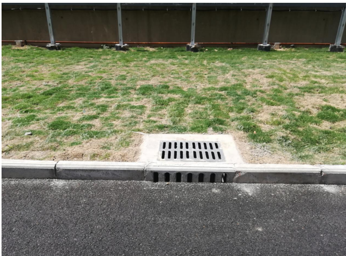
图片 12 厂区雨水口
